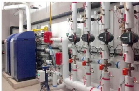
**Nos travaux :** *Création d'une chaufferie avec deux chaudières GAZ de 100 kw en cascade. Installation de 4 départs régulés vers des planchers chauffants, radiateurs, batterie terminales...*
